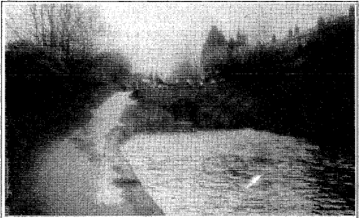
Lock overfill due to stuck paddle
